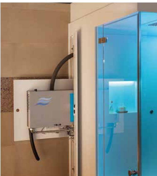
Dank dem integrierten Technikschrank bleibt die gesamte Technik ausserhalb des Duschbereichs verborgen. Der Hochleistungsgenerator leitet den warmen Dampf direkt in die Kabine. Über die Steuerung lässt sich die Temperatur exakt regeln – für ein Dampfbaderlebnis, das sich optimal geniessen lässt.
